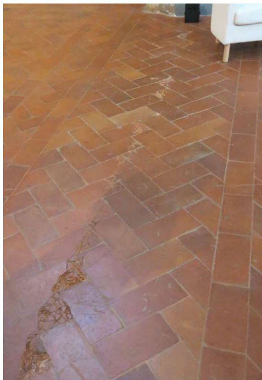
Lesione in corrispondenza dell'area di attacco della Corsia Lancisi con il Tiburio
