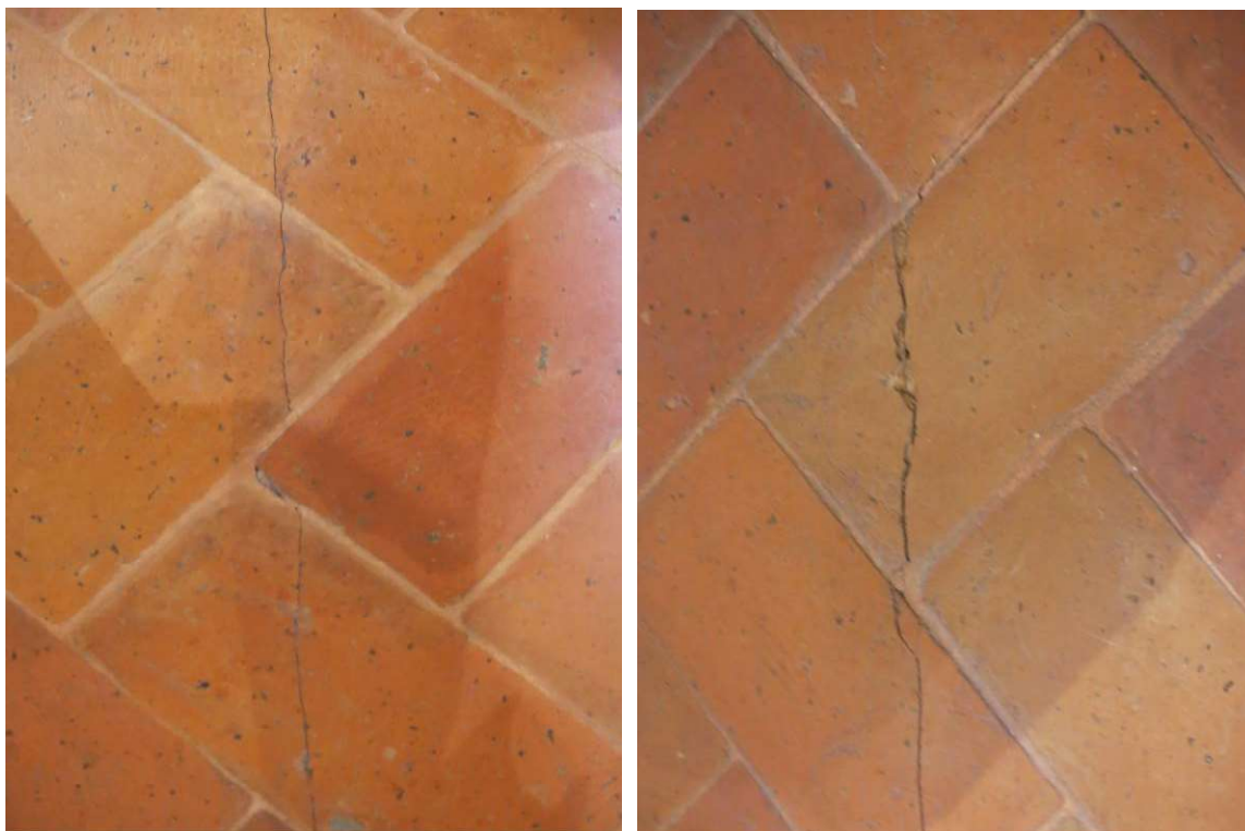
Altre lesioni trasversali lungo lo sviluppo della Sala Lancisi
