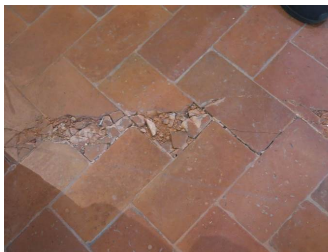
Lesione in corrispondenza dell'area di attacco della Corsia Lancisi con il Tiburio
